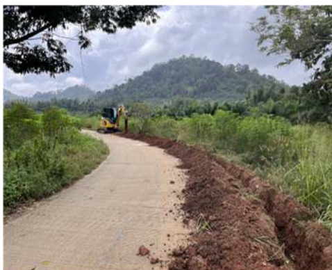
ขณะดำเนินงาน
