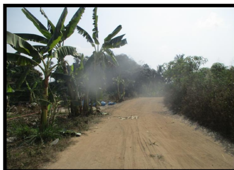
รูปขณะดำเนินการ
