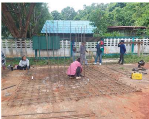
รูปขณะดำเนินงาน
