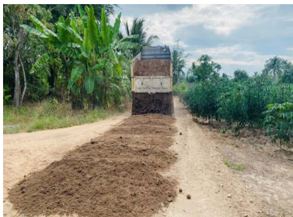
รูปขณะดำเนินงาน
