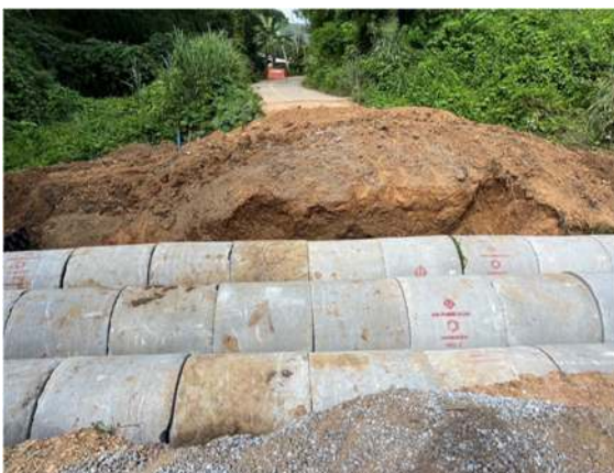
รูปขณะดำเนินงาน
